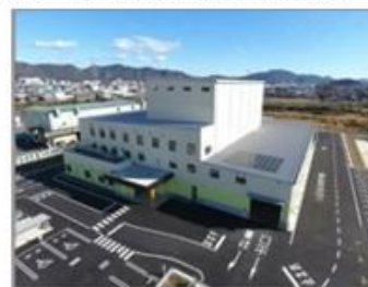
容器包装リサイクル推進施設
