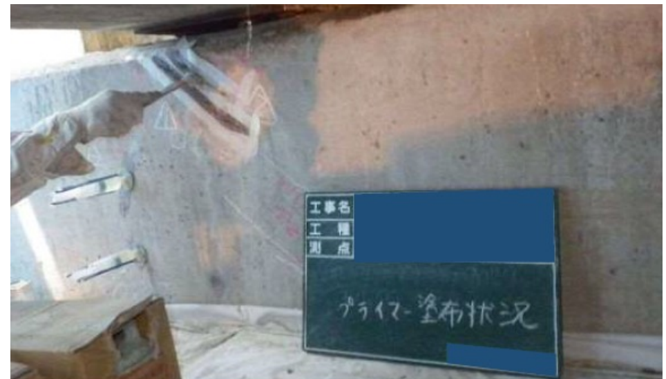
▲躯体補修（ひび割れ注入工法）
