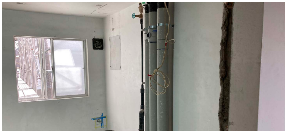
▲給排水管更新
