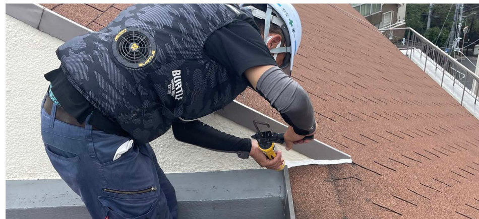
▲シーリング工事
