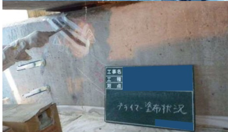
▲躯体補修（ひび割れ注入工法）
