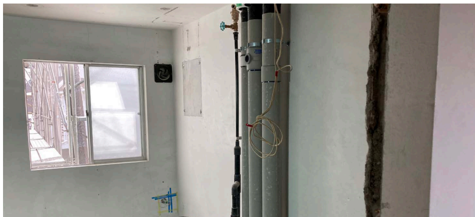
▲給排水管更新
