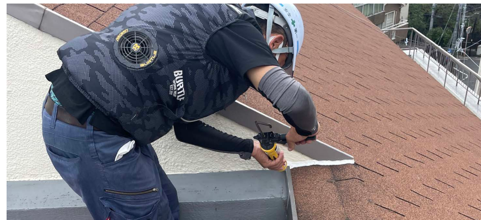
▲シーリング工事
