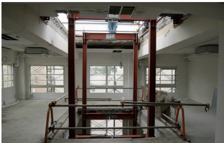
エレベーター新設
