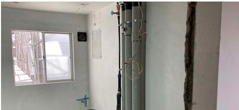
▲給排水管更新
