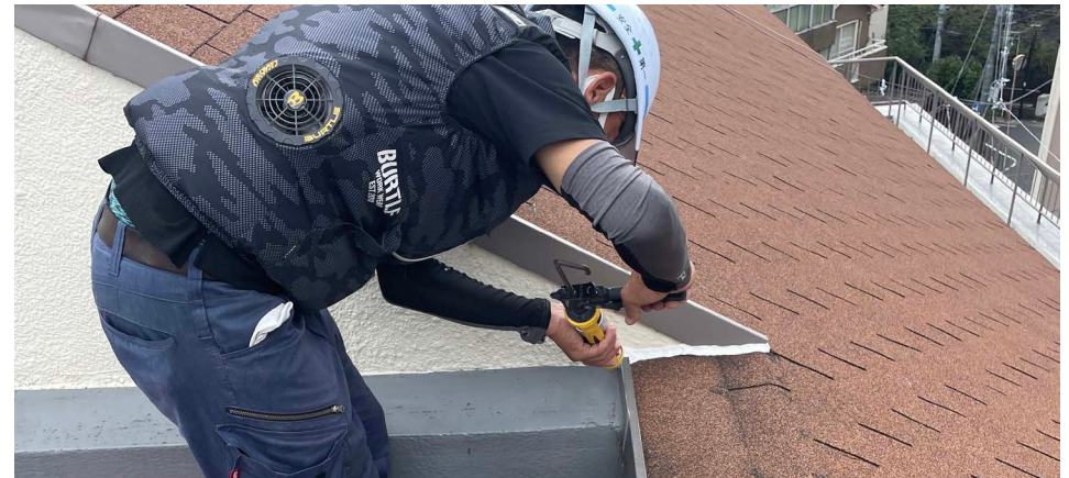
▲シーリング工事
