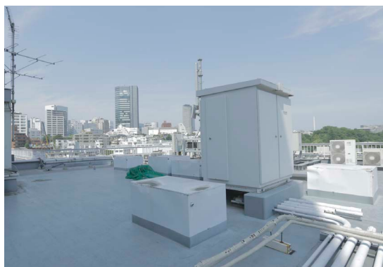
スカイテラス新設
