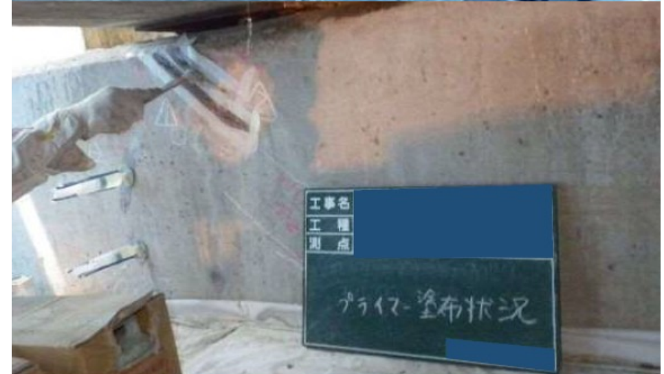
▲躯体補修（ひび割れ注入工法）
