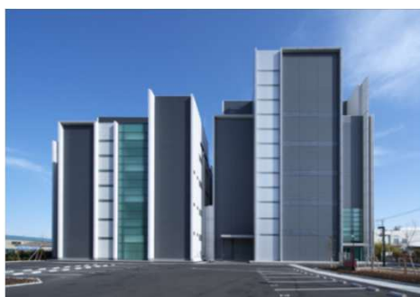
第2データセンター (横浜)
