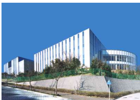
第1データセンター (横浜)
