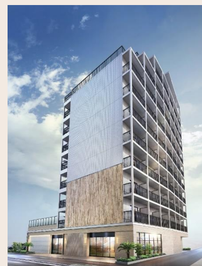
アルテシモ中野 2023年5月竣工
