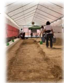
ベッドを設置する溝を掘り、地面を水平に整える
