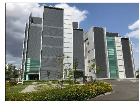
第2データセンター
