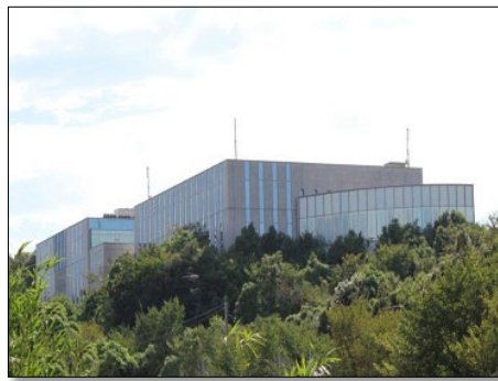
第1データセンター
