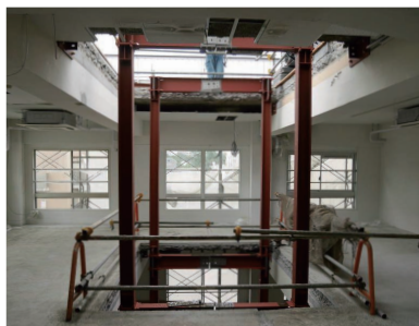
▲エレベーター新設
