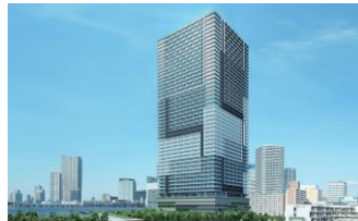
プラザタワー会津【東京都】
