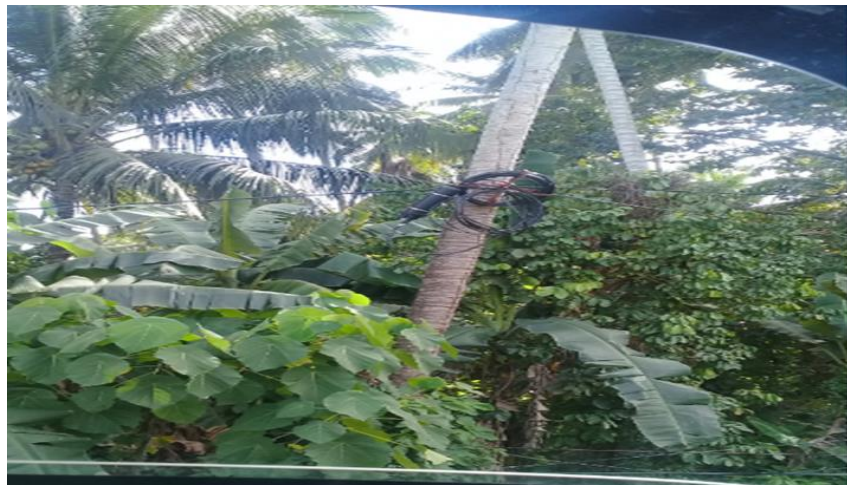
ヤシの木を電柱代わりに使っている大手通信事業者の例
